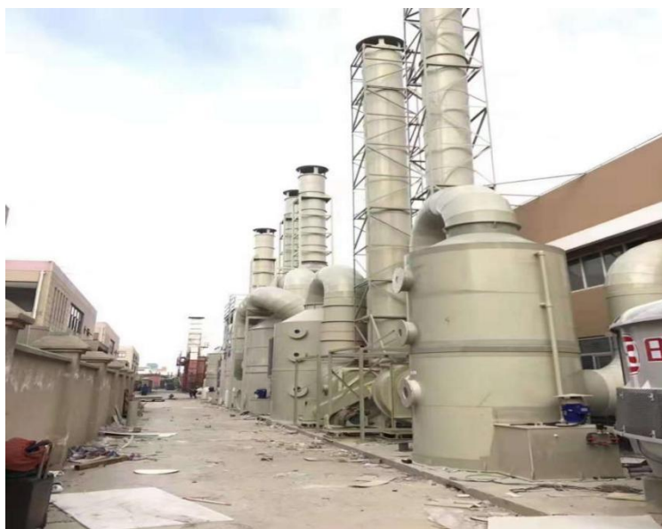
图 4-4 喷淋塔示意图
