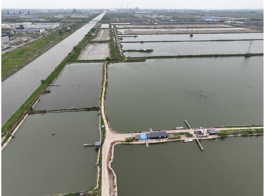
图 3-1 光伏区现状图
