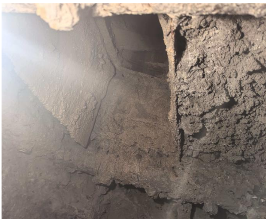
图 4 1#搅拌机仓与中途仓连接处（内部）
