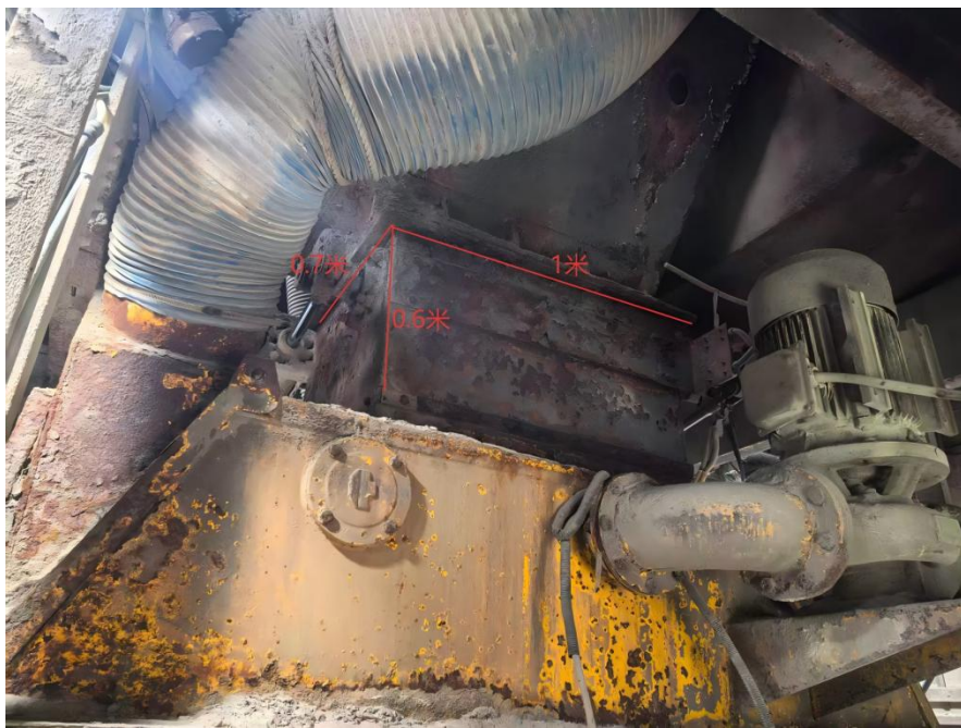
图 2 1#搅拌机中途仓（外部）
